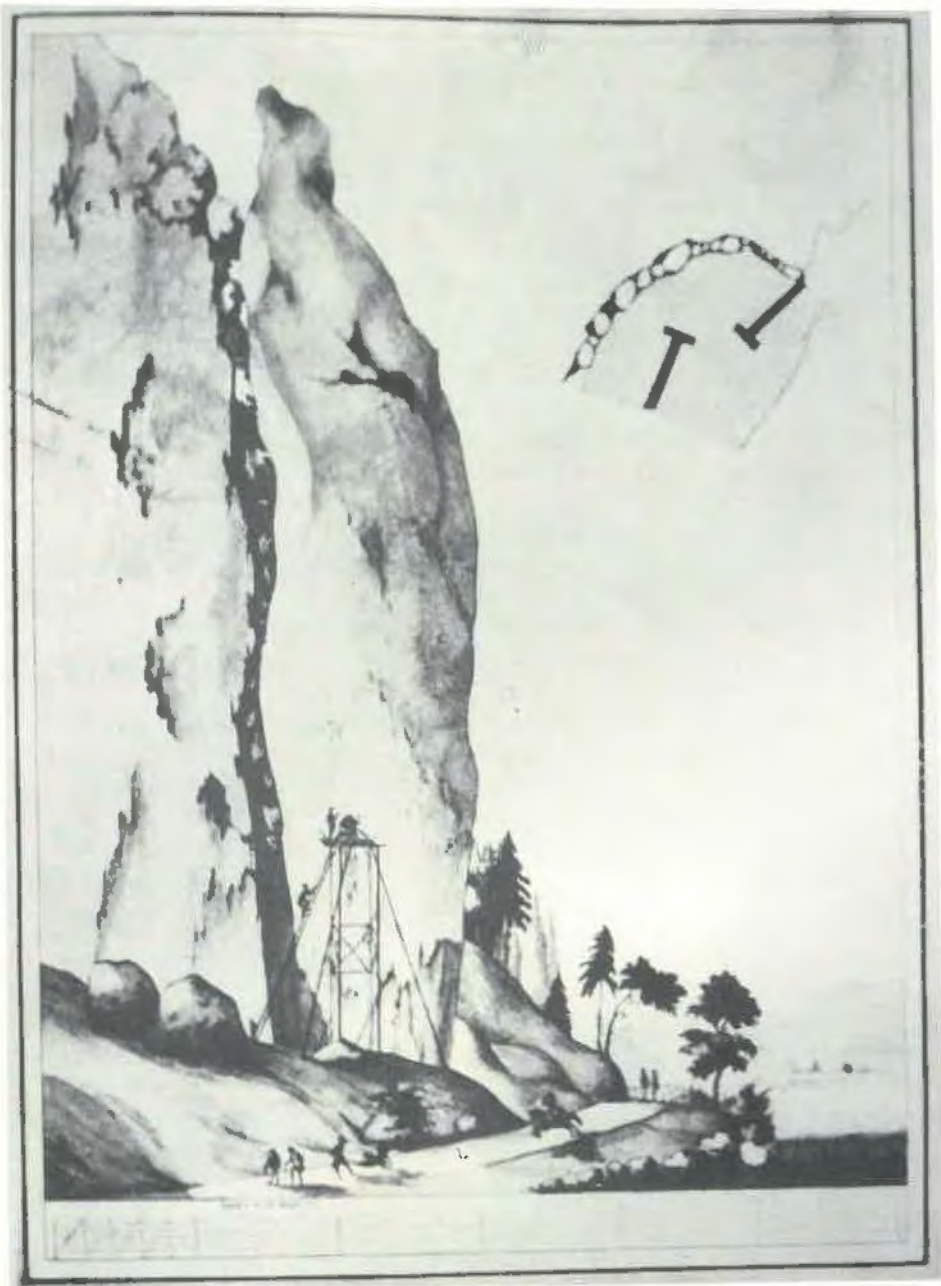
•Ansicht und Schnitt der Bohrlöcher am Teufelsfelsen•
