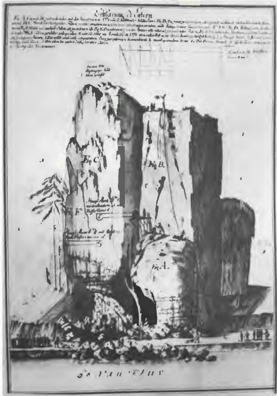
Ansicht der Sprengung und Abtragungsarbeiten am * Teufelsfelsen bei Abbach *
